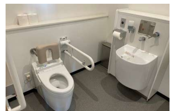
多目的トイレ
