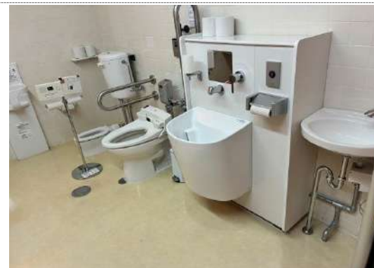
ビル3階 多目的トイレ入口幅85cm
