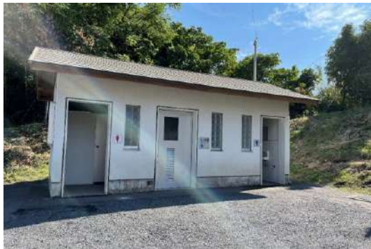
多目的トイレ外観
