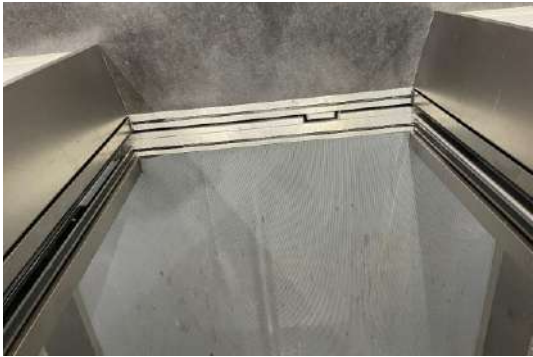
エレベーター幅入口幅90cm
