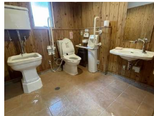
多目的トイレ
