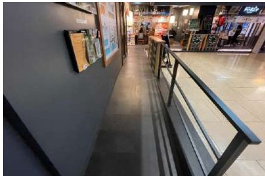
各エリア毎にスロープあり
