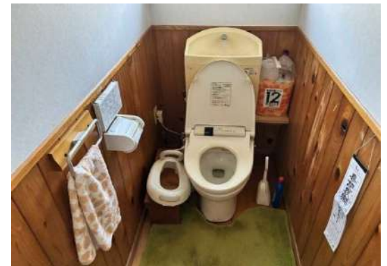
トイレ入口幅53cm
