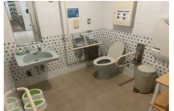
多目的トイレ
