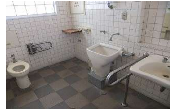
多目的トイレ
