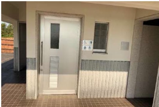
多目的トイレ入口
