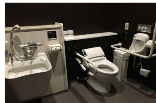
多目的トイレ
