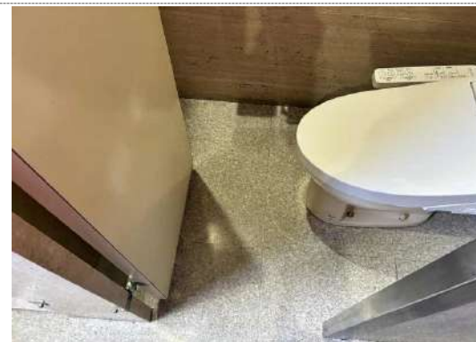
個室トイレ入口幅47cm
