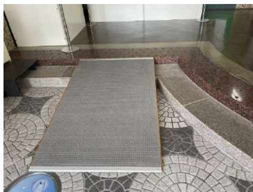
正面入口内スロープ
