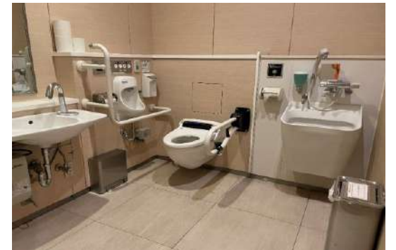
多目的トイレ
