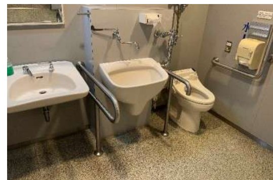
多目的トイレ
