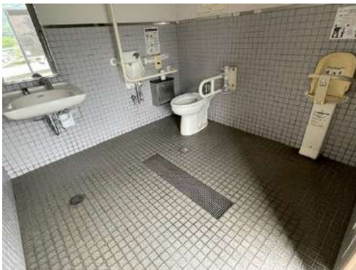
管理事務所横多目的トイレ入口幅104cm
