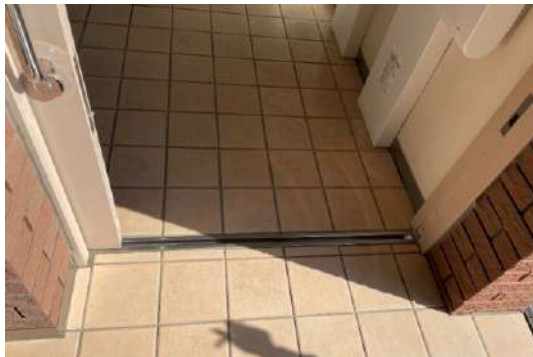
多目的トイレ入口
