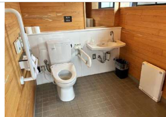
一般駐車場内多目的トイレ入口幅88cm
