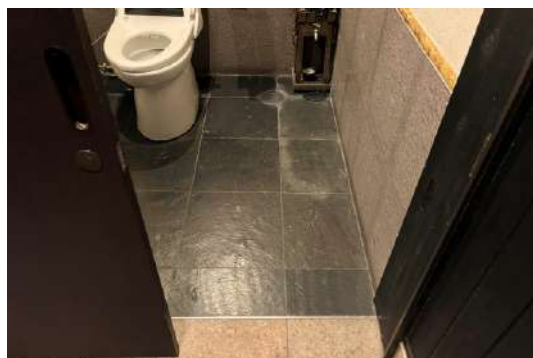
多目的トイレ入口幅70cm
