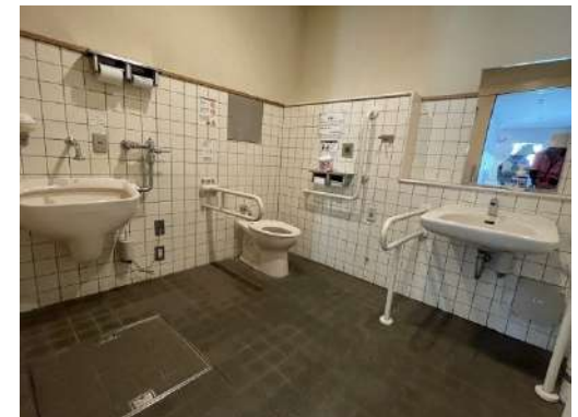
管理事務所内多目的トイレ入口幅94cm
