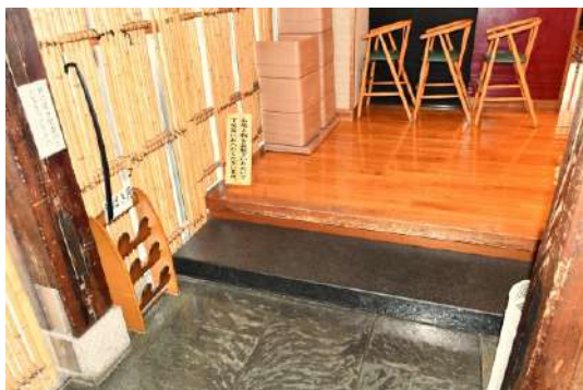
2階入口（段差あり）
