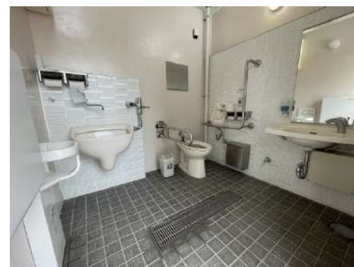
多目的トイレ 入口幅90cm
