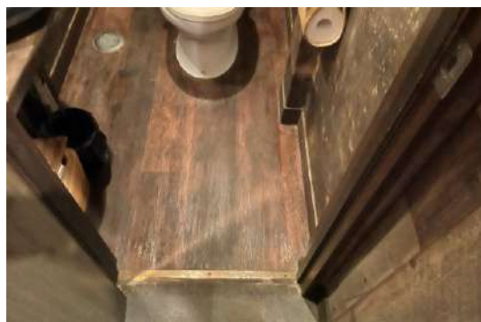
トイレ個室入口幅54cm
