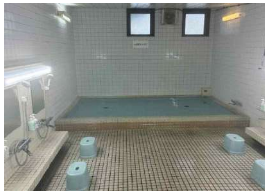
大浴場 入口幅120cm、段差10cm
