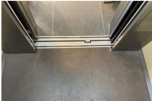
桜華亭/エレベーター入口幅80cm
