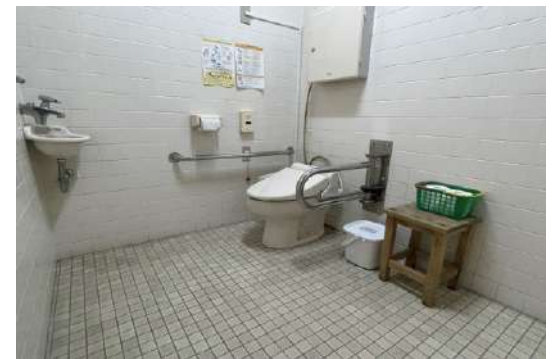
多目的トイレ
