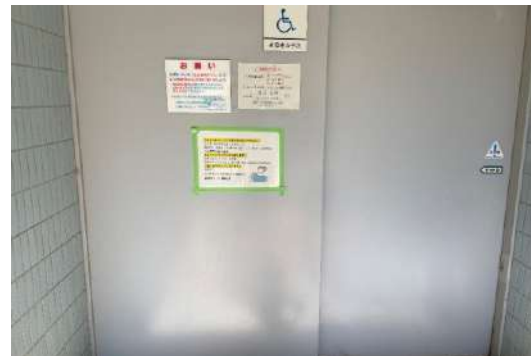
バリアフリートイレ入口
