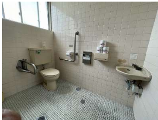
多目的トイレ 入口幅84cm
