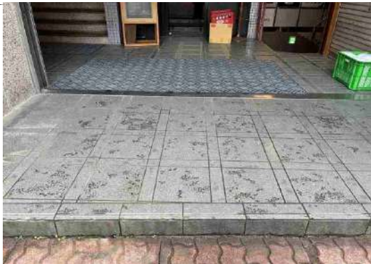
入口幅開放 段差12cm
