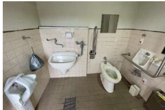
多目的トイレ
