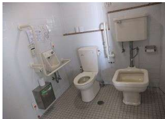
多目的トイレ
