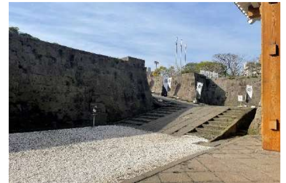
御楼門/砂利道あり
