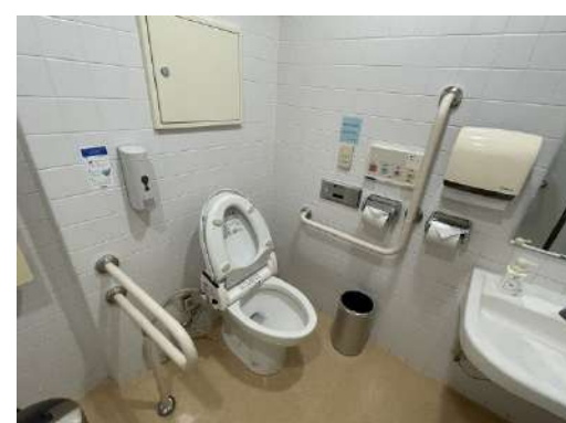
多目的トイレ入口幅95cm
