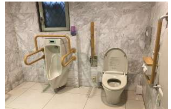
多目的トイレ
