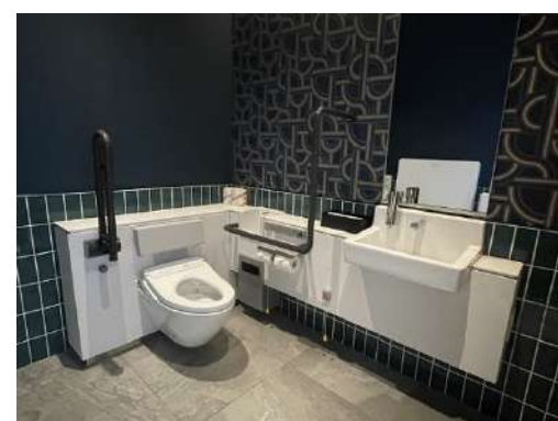
多目的トイレ入口幅85cm
