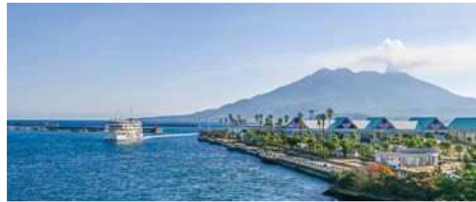
鹿児島港に入港する桜島フェリー
