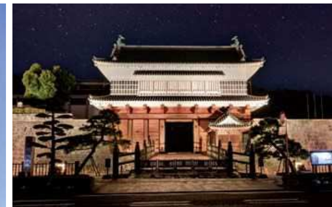
2020年に復元された鹿児島(鶴丸)城御楼門のライトアップ
